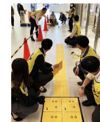
従業員による敷設の様子
