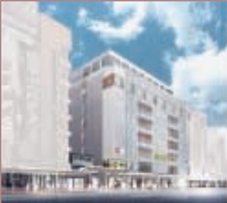
■ 京都東宝ビル（4月竣工）
