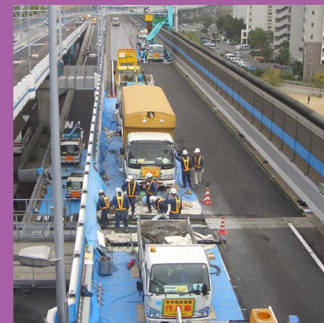
高速道路の補修工事
