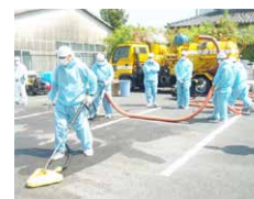
高圧洗浄吸引による除染
