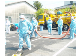
▲ 高圧洗浄吸引による除染
